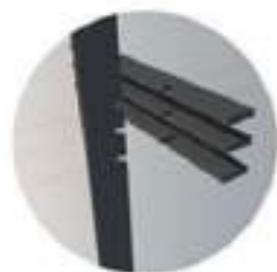
TRAVAMENTO ENTRE AS PLACAS METÁLICAS POR MEIO DE ENCAIXE, SENDO AS PLACAS HORIZONTAIS FIXADAS NOS PILARES ESTENDIDOS, ASSIM COMO AS PLACAS VERTICAIS SÃO FIXADAS NA LAJE ESTENDIDA, POR MEIO DE CANTONEIRA.
