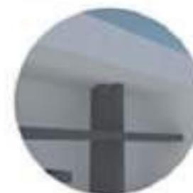
PLACA METÁLICA DE ESPESSURA 0,05m, FIXADA À LAJE DE CONCRETO POR MEIO DE CANTONEIRAS METÁLICAS E DE PARAFUSOS
