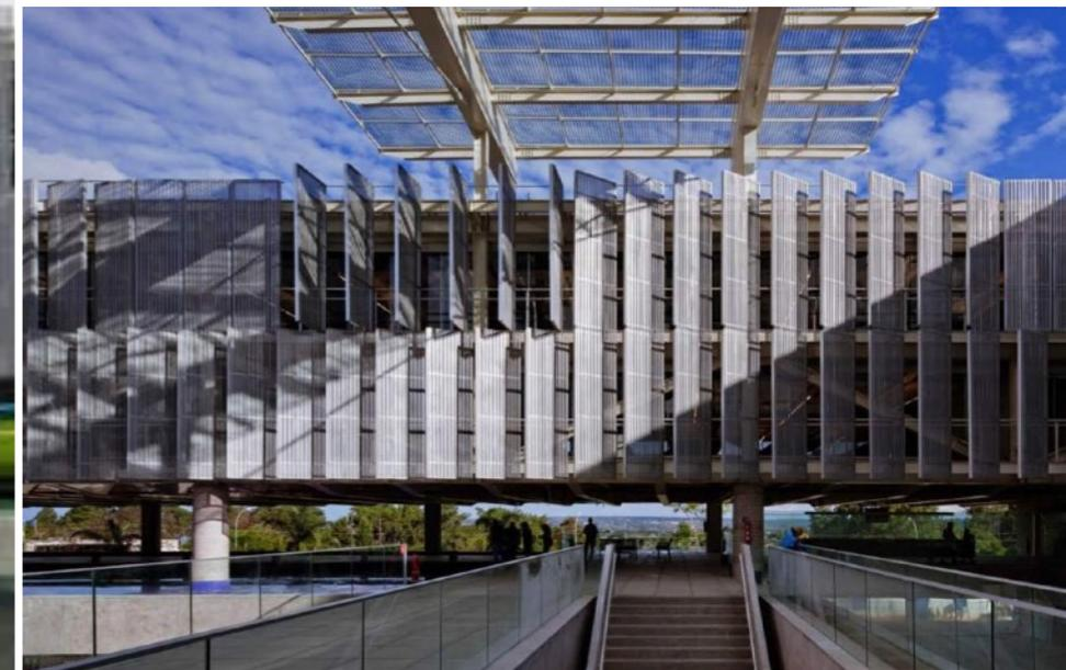
Duas **VIGAS VAGÃO** de **3,60** metros de **altura**, vencendo um **vão** de **36 metros**.
