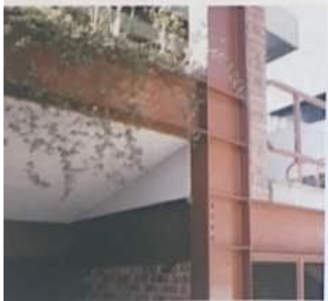
NÓ DE PÓRTICO - CONEXÃO RÍGIDA EMPREGANDO CONEXÃO SOLDADA VIGA - PILAR
